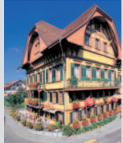
Mit der bevorstehenden Remodelation der Kernzone Sumiswald wird die «Bären»-Terrasse vergrössert und neu gestaltet.
